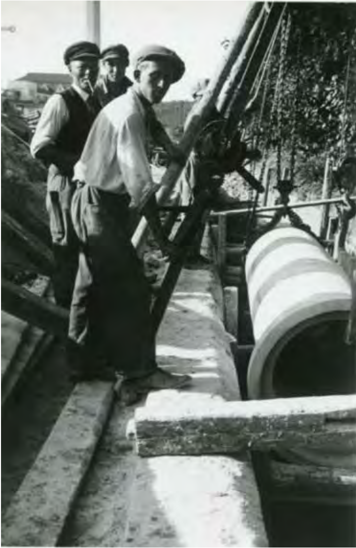
Ellwangen, Verlegung von Kanalisationsrohren (Stadtarchiv Ellwangen)
