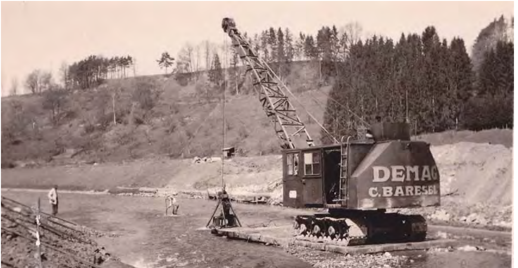
Abtsgmünd, Aushebung des durch Hochwasser verlandeten Kocherbetts (Gemeinde Abtsgmünd)
