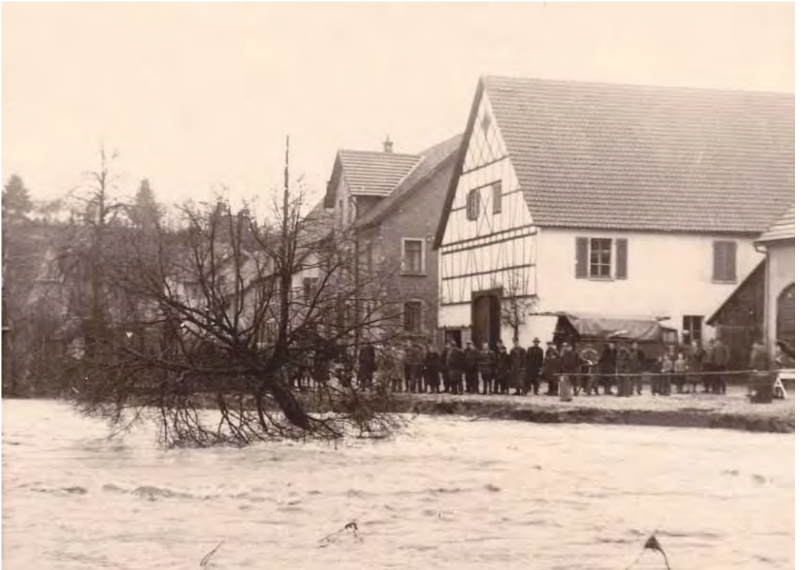
Abtsgmünd, Hochwasser am 3. März 1956 (Gemeinde Abtsgmünd)
