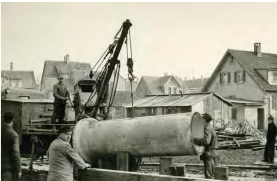
Aalen, Verlegung der Hauptsammeldohlen für den Bau der Sammelkläranlage (Günter Wenzel)
