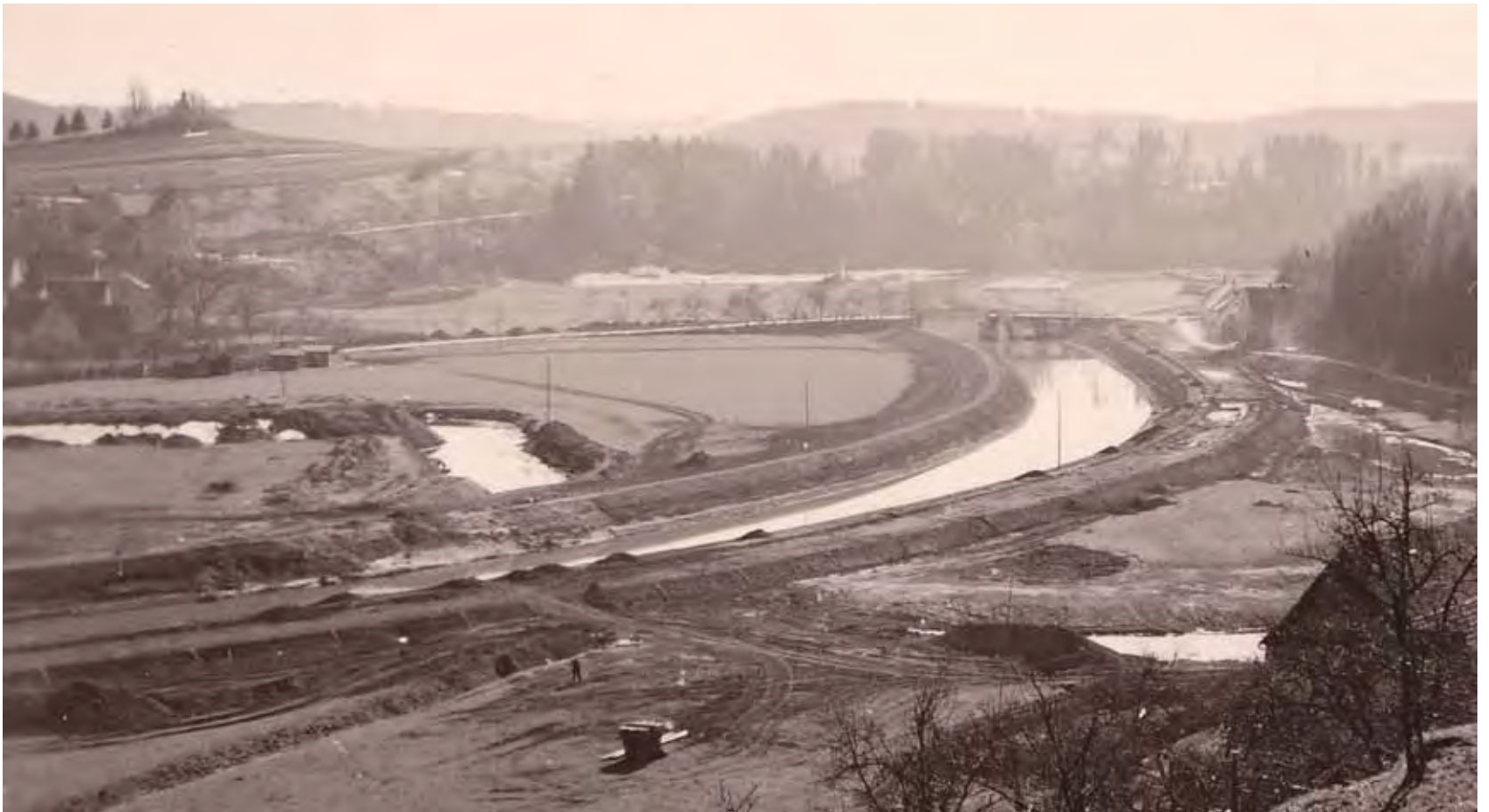
Abtsgmünd, der neue Kocherbogen in Abtsgmünd ist fertiggestellt, die alte Flußschleife ist noch erkennbar. März 1953 (Gemeinde Abtsgmünd)
