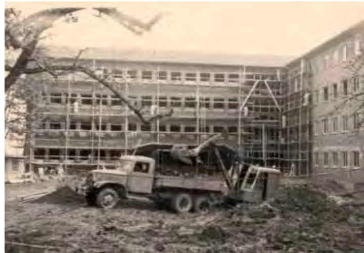
Baustelle Kreiskrankenhaus in Aalen
