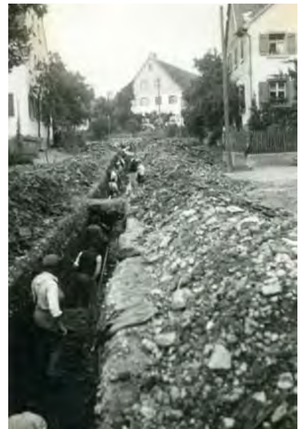
Walzheim bekommt 1951 die Kanalisation, Wasserleitung und Entwässerungsrohre wurden komplett in Handarbeit in den felsigen Untergrund der Hauptstraße gemeißelt und gegraben. (Bild oben und unten Otto Rössle)
