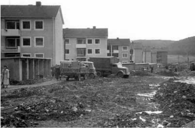
Oberkochen, Walter-Bauersfeld-Strasse im Bau 1957 (Heimatverein Oberkochen)
